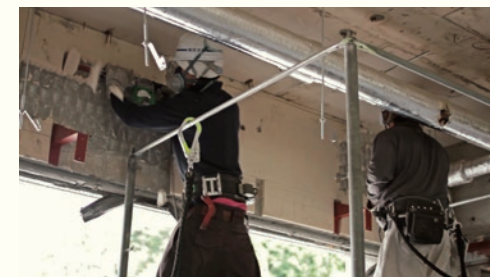
南三陸の解体 / Dismantling in Minamisanriku 2012年9月—2013年1月 / September 2012 to January 2013 宮城県南三陸町 / Minamisanriku Town, Miyagi 高野裕之 / Hiroyuki Takano
